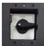
BYPASS DE MANTENIMIENTO
